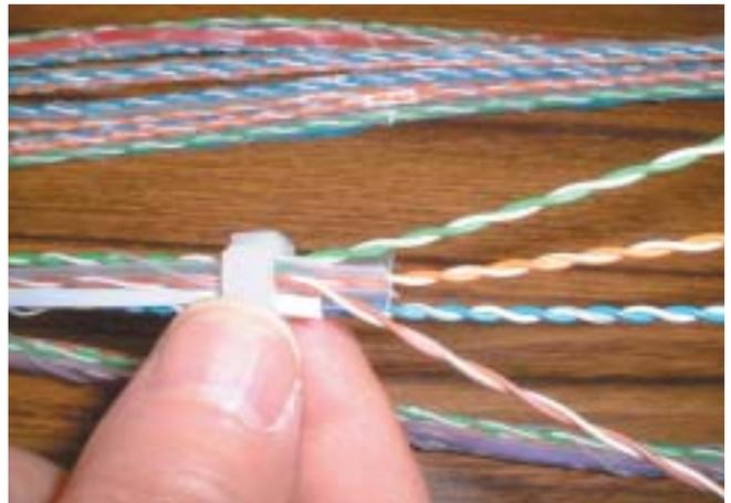
③ ナイロンバンド、クリップルで十字型介在から対がバラけるのを防ぎます。この時、つづいてジャックの成端に入るためナイロンバンド、クリップル(内径5mm)の止める位置は端末から5cmぐらいの所にします。(上図、左:ナイロンバンド、右:クリップル)
