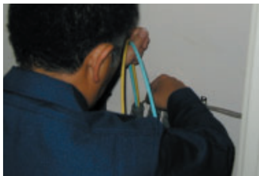
【写真4】 シャフトへの通線作業
