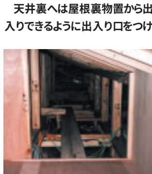
(写真5) 天井裏への出入り口
