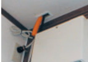
(写真4) 納戸天井の配線口
