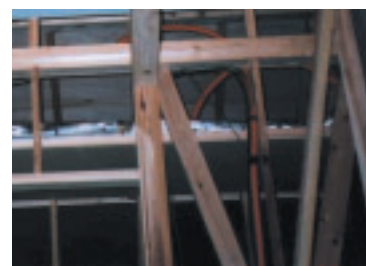
(写真3) CD管の様子
