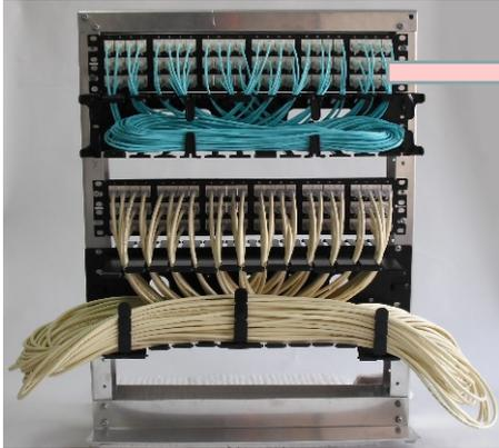
細径(上段)と通常径(下段)の比較。
